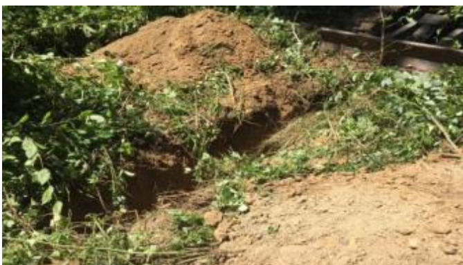
Sondage S6 – Zone de stockage
