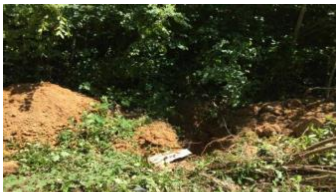
Sondage S5 – Zone de stockage
