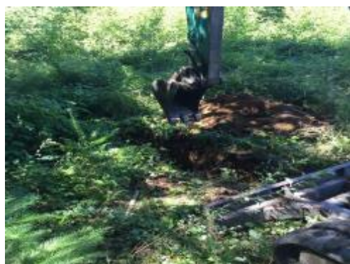
Sondage S7 – Zone de Stockage
